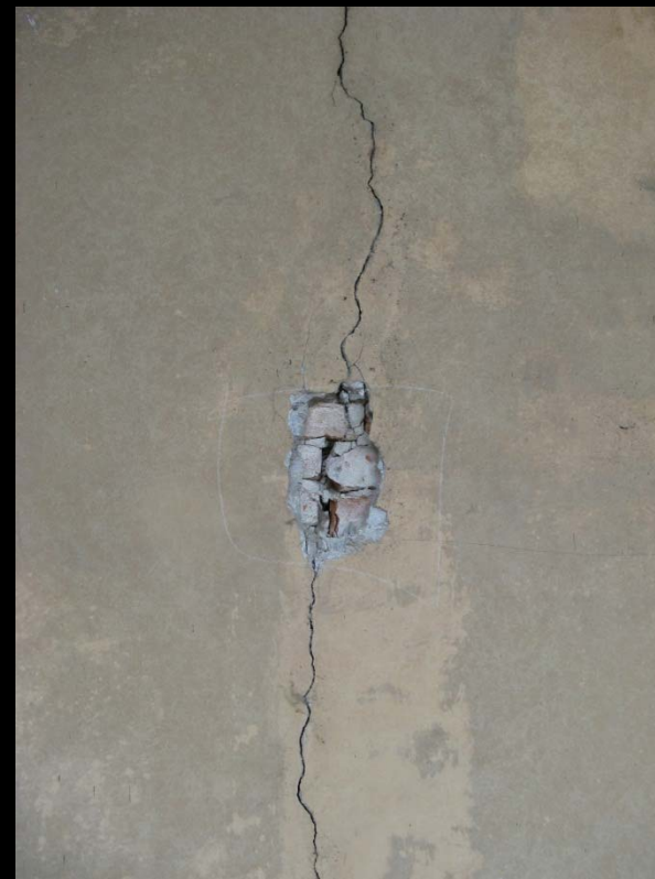
Lesione piano secondo Particolare
