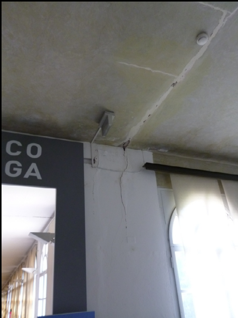
Lesioni sulle strutture verticali
